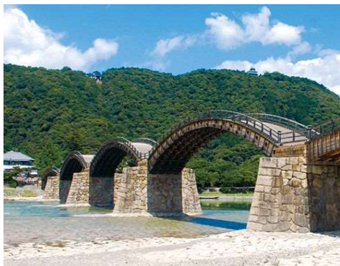
錦帯橋（岩国市 HP より）
