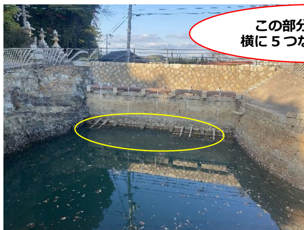
排水口（正面から）
