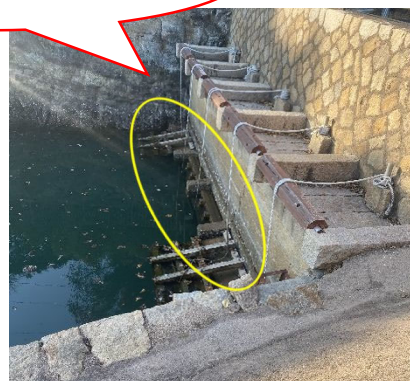
排水口（側面から）
