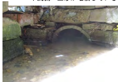
下流側 土砂が堆積している
