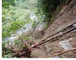
⑤: EP側のり尻崩壊状況
