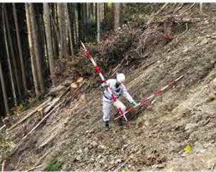
④: 法面中腹崩壊状況
