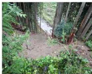
⑧: EP側のり尻崩壊状況
