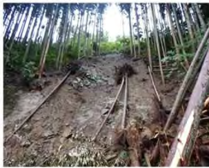
⑥: BP側のり尻崩壊状況
