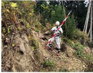
⑤: EP側のり尻崩壊状況
